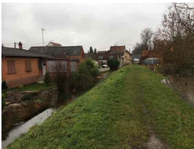
La digue qui protège le village.
