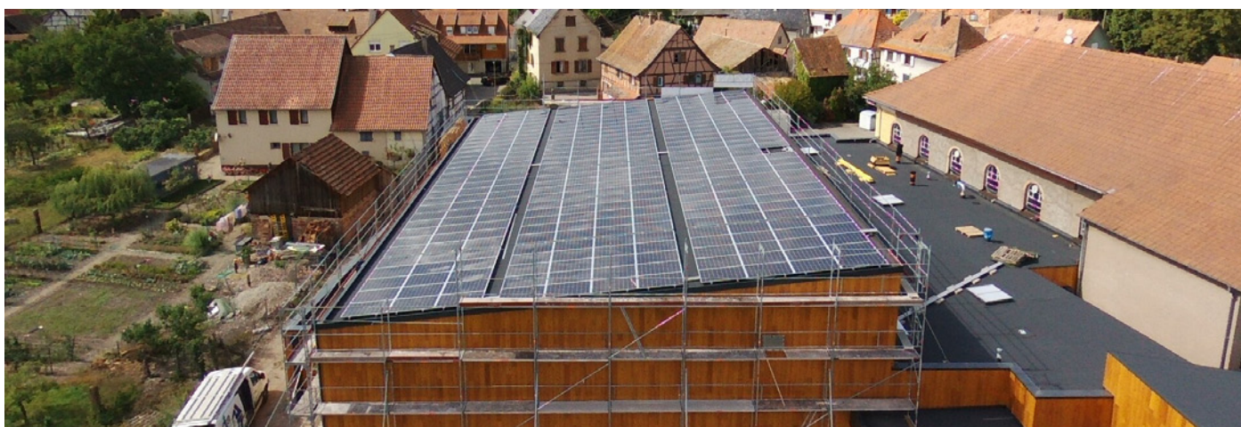
Grâce aux 600 m 2 du toit photovoltaïque, le gymnase autoconsomme une grande partie de son électricité.
