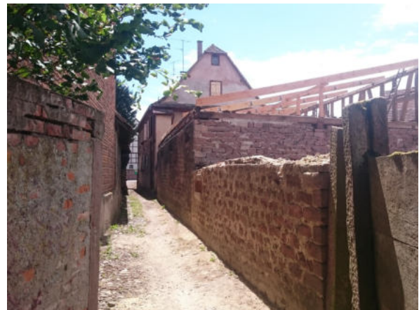
La "rue" des Jardins au niveau de son débouché sur la rue de Welschinger
