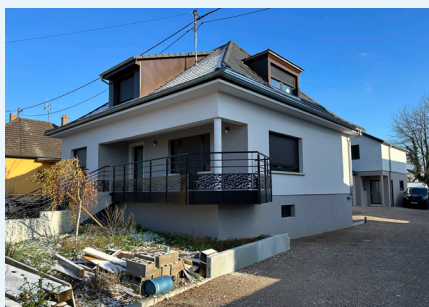
Rue Dadelsen : 1 logement conventionné.
