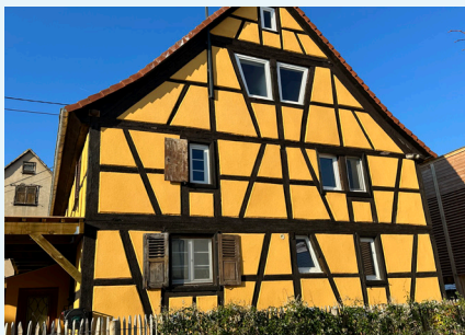
Rue de la Paix : 2 logements.
