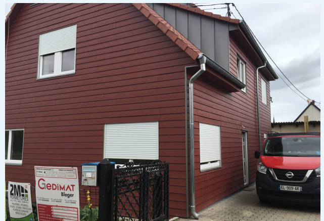
Rue des vétérans : 1 maison rénovée.
