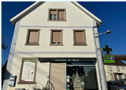
La Pharmacie, rue Welschinger : deux logements conventionnés.
