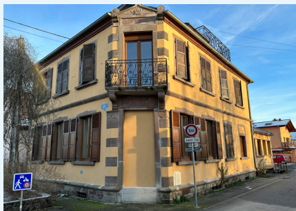
La Vieille poste, rue des tulipes : 3 logements en accession.
