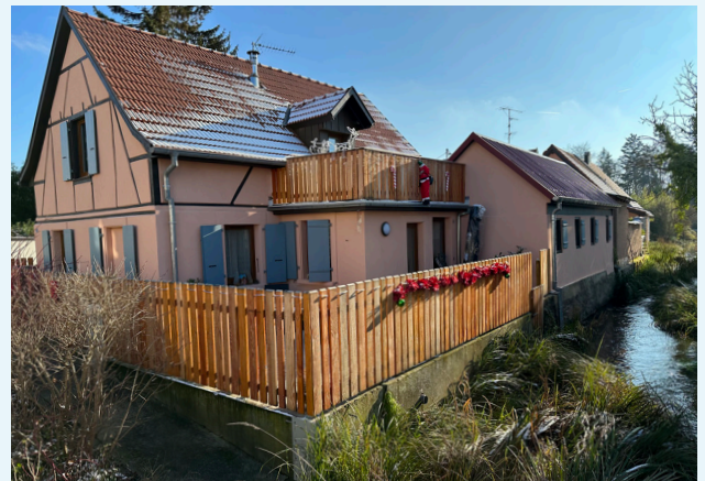
Rue de Wittisheim : 1 maison rénovée.
