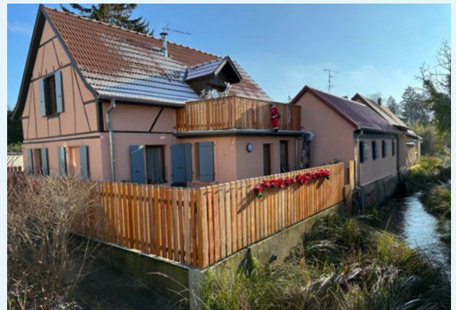
Rue de Wittisheim : 1 maison rénovée.
