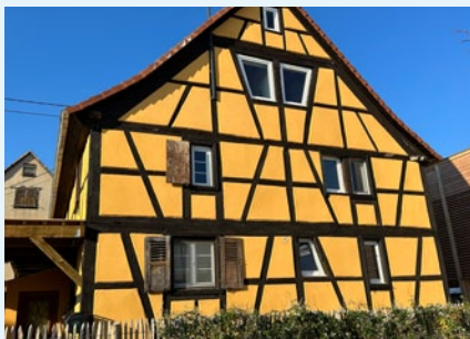
Rue de la Paix : 2 logements.
