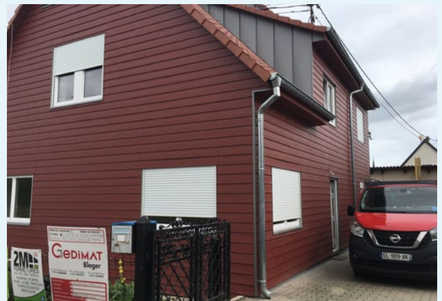
Rue des vétérans : 1 maison rénovée.
