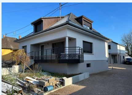
Rue Dadelsen : 1 logement conventionné.
